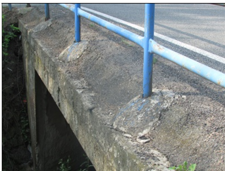
Silně převrstvená vozovka, obetonování sloupků zábradlí
