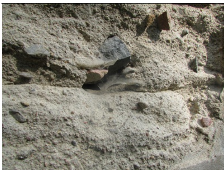
OP1 - levá strana - degradace betonu
