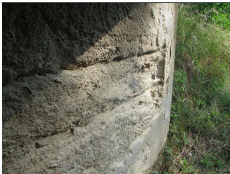
OP1 - levá strana - degradace betonu
