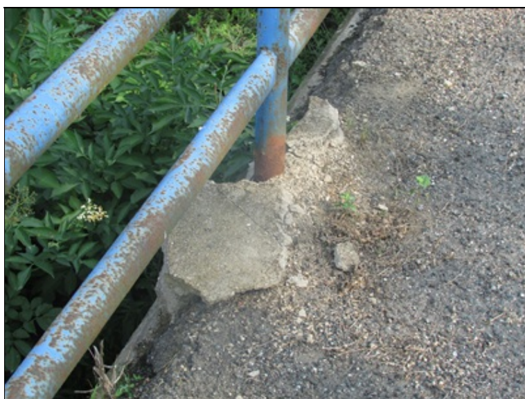
Obetonované kotvení zábradlí
