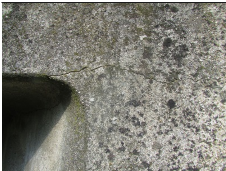
trhlina v místě uložení NK na OP1 vlevo
