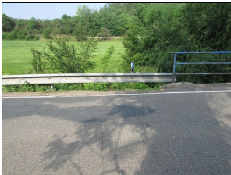
Uvolněný konec svodidla
