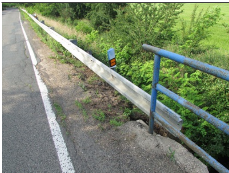
Uvolněné napojení svodnice
