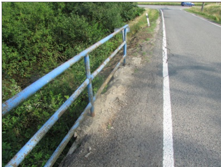
Rozpad římsy na levé straně
